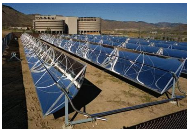
Fig. 7. Concentradores cilíndrico-parabólicos
